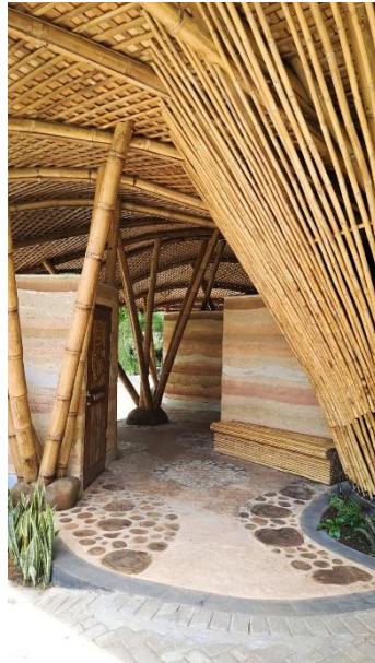
Gambar detail struktur yang berirama. (Sumber: Dokumentasi Pribadi, 2026)
