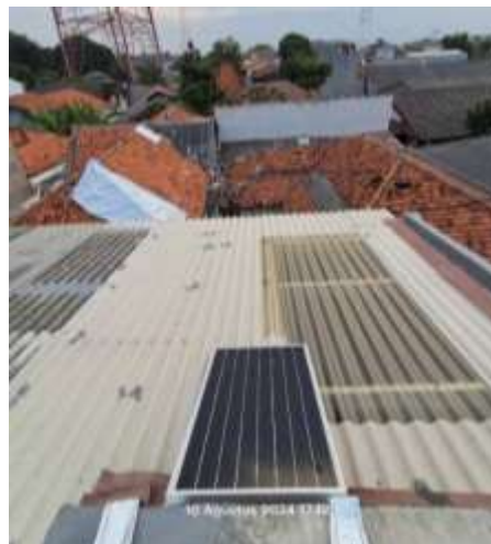
Gambar 3. 3 Penempatan panel surya
