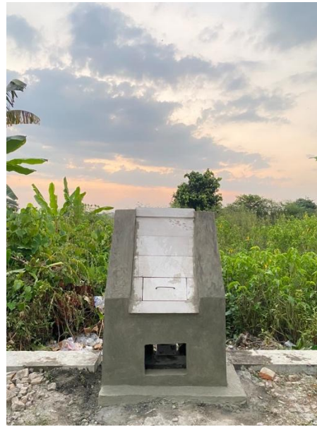
Gambar 3. Hasil Rocket Stove sebelum finishing .
