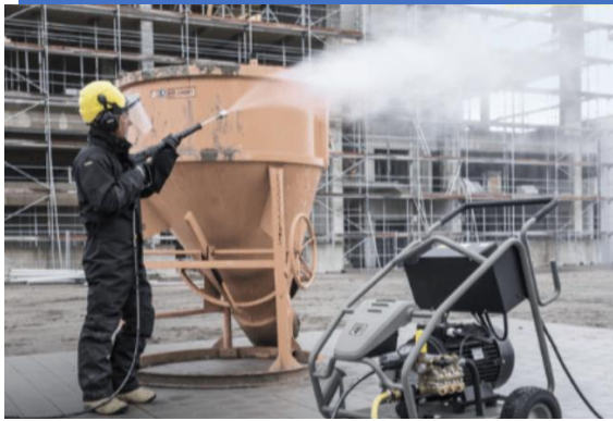
Gambar 4. Alat perlindungan diri standard bagi pekerja yang memakai sistem bertekanan tinggi.
